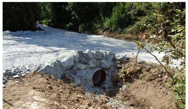
Verlegung eines 800 mm Durchlasses
