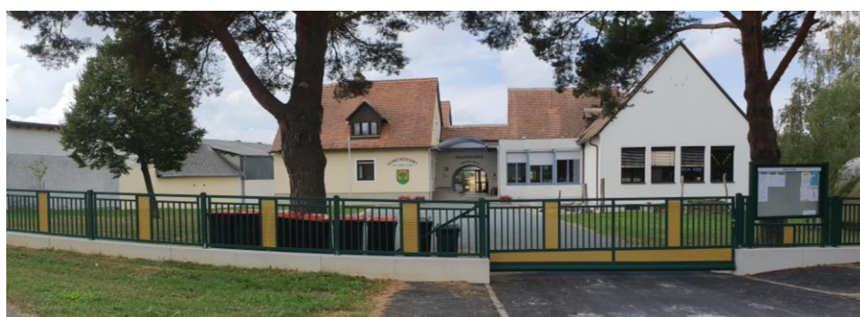
Volksschule u. Gemeindeamt – Neue Einfriedung
